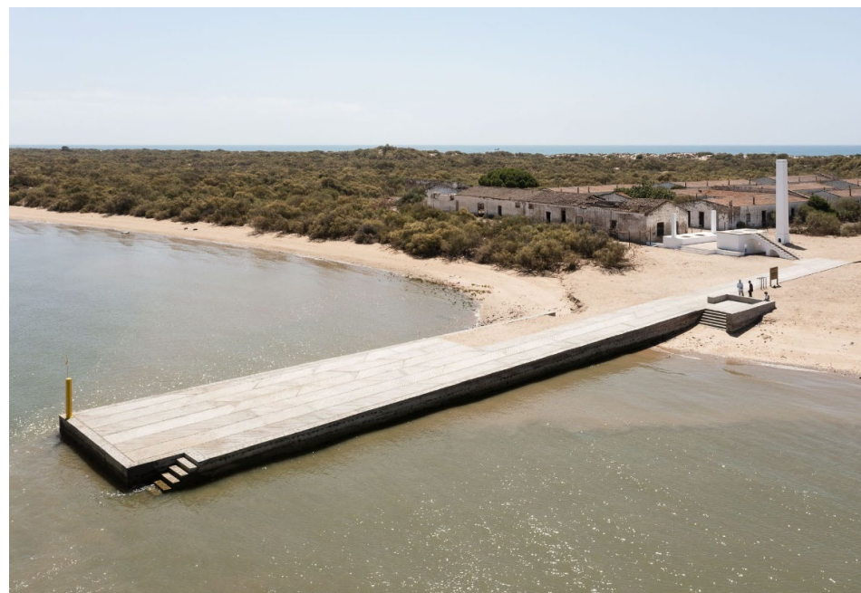
Espigón en la Alameda do Rompido, España. Fuente: Sol89 Arquitectos.
