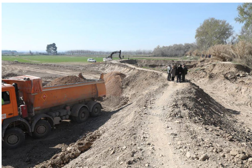
Trabalhos de consolidação da mota de proteção no rio Ebro. Fuente: El Periódico de Aragón.
