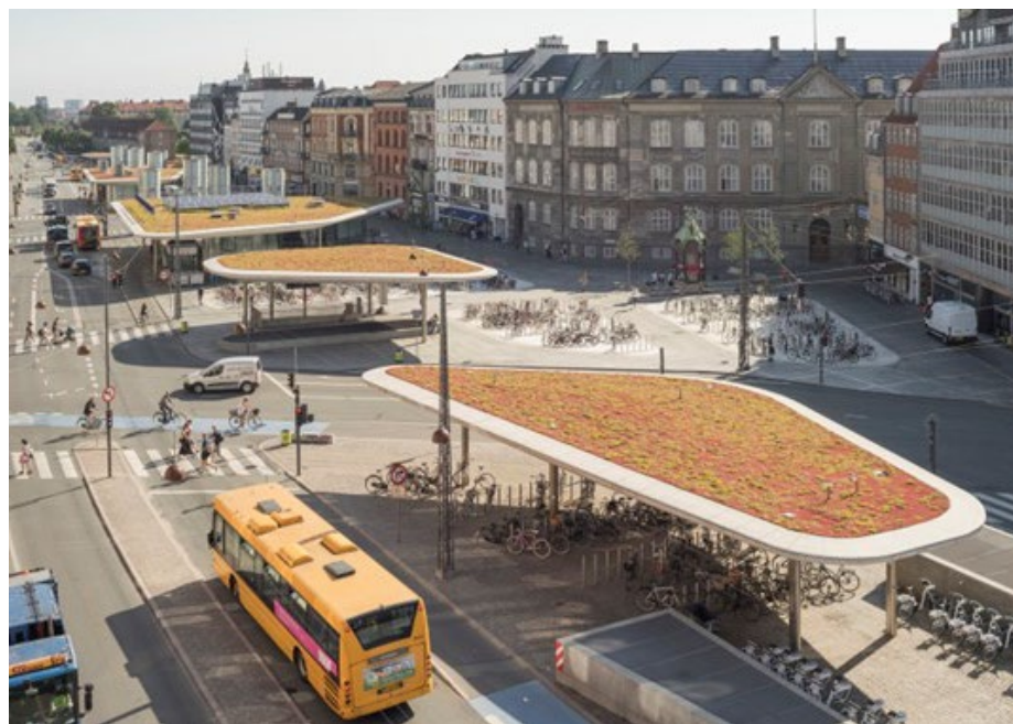
Estação intermodal, Nørreport Station, Copenhagen. Fuente: ArchDaily.
