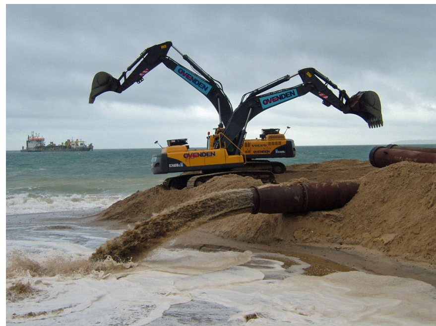
Trabalhos de regeneração de praias na Bahía de Poole, Reino Unido. Fuente: BCP Council.
